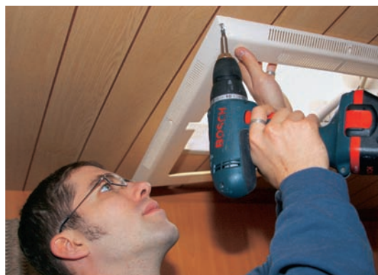
2 Völlig losgelöst: Die Schrauben des Dachluken-Rahmens lassen sich bequem mit einem Schrauber entfernen.
