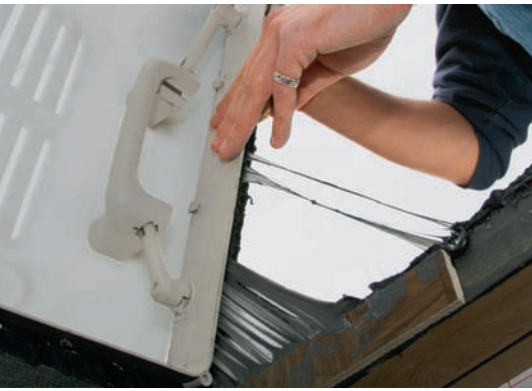
4 Kaugummi: Nach sanftem Hebeln mit einem Keil kann die Luke abgezogen werden.
