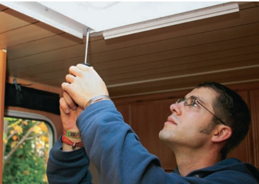
7 Handarbeit: Beim Festschrauben des Montagerahmens quillt oben die Dichtmasse.
