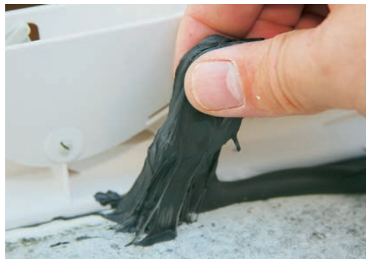
11 Leichtes Spiel: Neue Dichtmasse kann nach nur einigen Tagen Trocknung leichter entfernt werden als alte.
