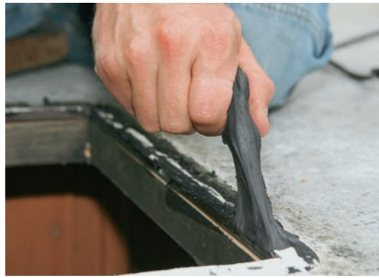
5 Mühsam: Die alte Dichtmasse klebt um ihr Leben. Es hilft nur „Abtupfen“ mit dem gleichen Material.
