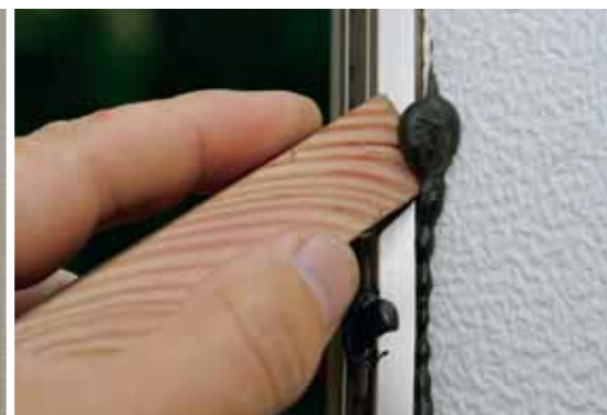
11 Abziehen: Nach drei Tagen lässt sich überstehender Kleber mit einem Holzkeil abtrennen.
