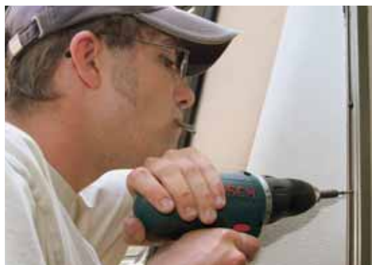
10 Finale: Die Schrauben sollten gut sitzen – so anziehen, dass seitlich reichlich Dichtmasse austritt.
