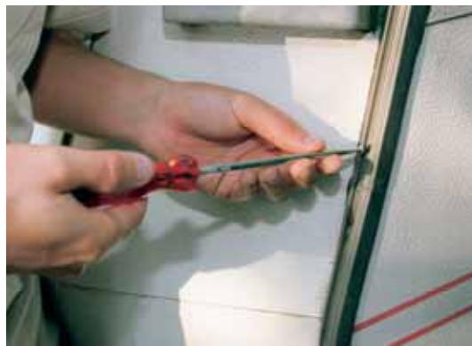
4 Losgelöst: Jetzt lässt sich der Schraubenkopf mit einem Flachschrabenzieher packen.
