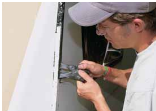
7 Geduldprobe: Die alte Dichtmasse wird mit dem gleichen Material komplett abgezupft.
