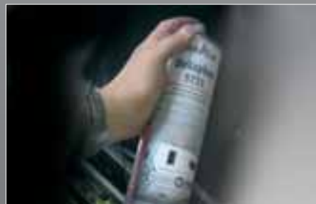
Aufspritzen auf Holzbodenplatten
