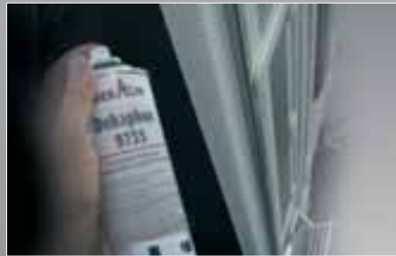
Aufspritzen auf Holzbodenplatten
