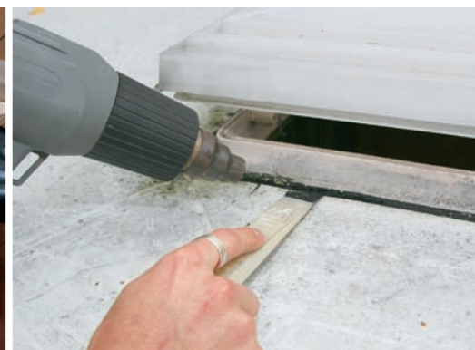
3 Heiß gemacht: Das Aufwärmen der alten Dichtmasse bitte mit Gefühl, nicht übertreiben.
