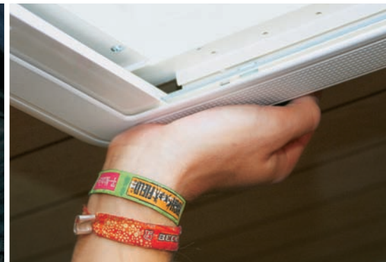
9 Angedrückt: Der Rollorahmen wird mit sanftem Druck auf den Montagerahmen geschoben.
