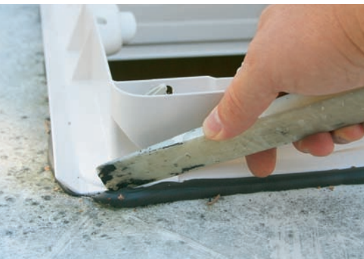
10 Schneidig: Klebereste lassen sich am besten mit einem Keil „abschneiden“.
