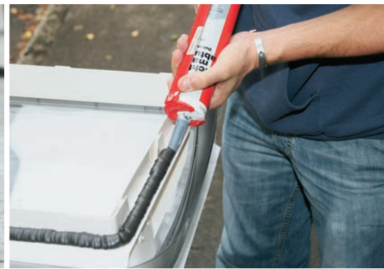
6 Großzügig: Der Querschnitt der Kartuschendüse bestimmt die Größe der Raupe. Bitte nicht sparen.
