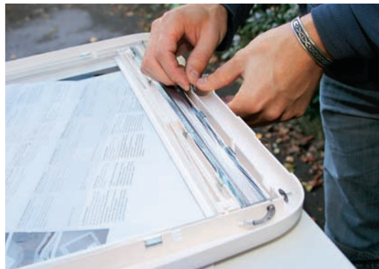
8 Eingeklipst: Neue Montageklammern halten später den Rahmen, in welchem die Rollos laufen.
